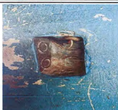
Foto 8: Sustitución de apagadores dobles
