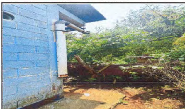
Foto 9: Sustitución de bajada de Agua Pluvial
