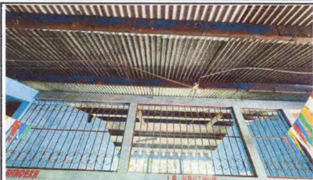
Foto 7: Reparación de Sistema Eléctrico
