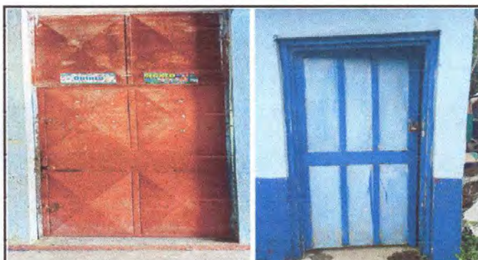
Foto 3: Mantenimiento a estructura de Puertas (lijado, cambio de tubo , cepillado, sujeciones, aplicación de pintura)
