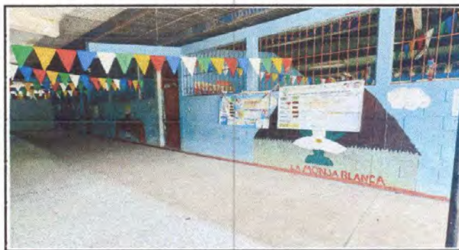
Foto 6: Pintura en muros exteriores e interiores
