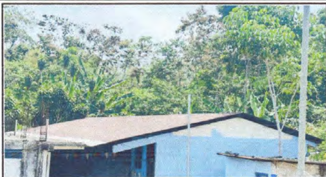
Foto1: Sustrucción de lamina troquelada calibre 26
