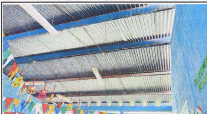
Foto 2: Mantenimiento a estructura de soporte de metal
