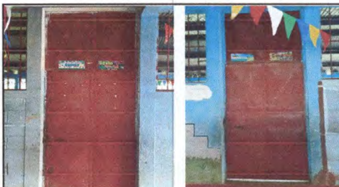
Foto 4: Mantenimiento a estructura de Puertas (lijado, cambio de tubo , cepillado, sujeciones, aplicación de pintura)
