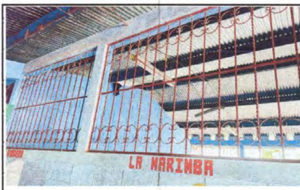
Foto 10: Mantenimiento a balcones de metal
